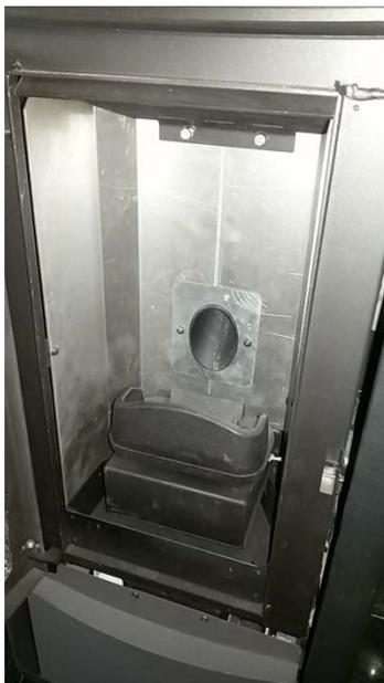
Un simple control visual, efectuado diariamente, permite controlar la eficiencia y limpieza del brasero. Para una limpieza eficaz dl brasero, extraerlo completamente de su base y limpiar a fondo todos los agujeros.
